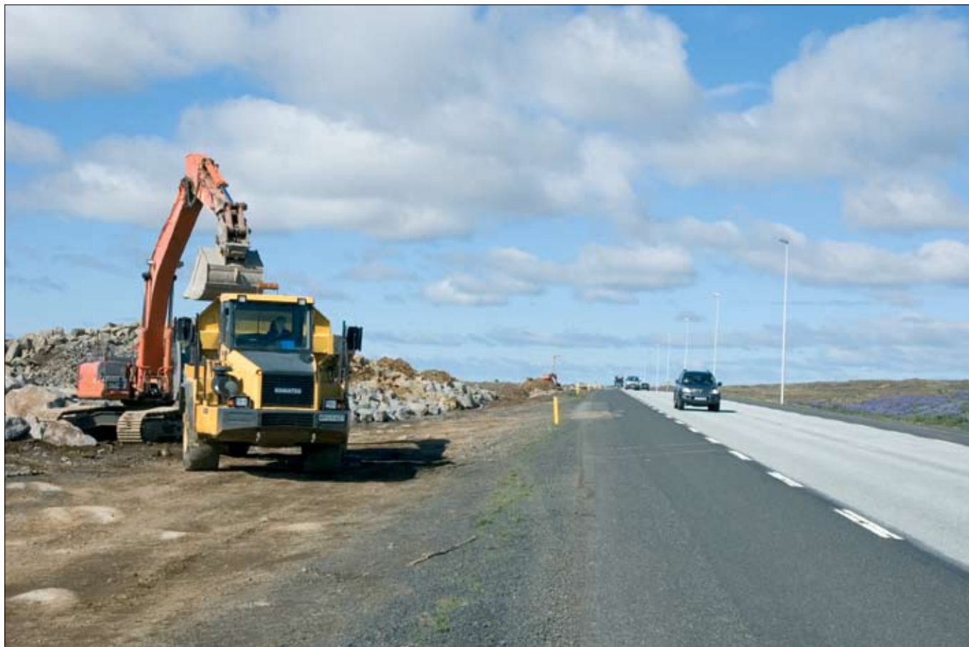
Framkvæmdir við tvöföldun Reykjanesbrautar í júní 2006.
